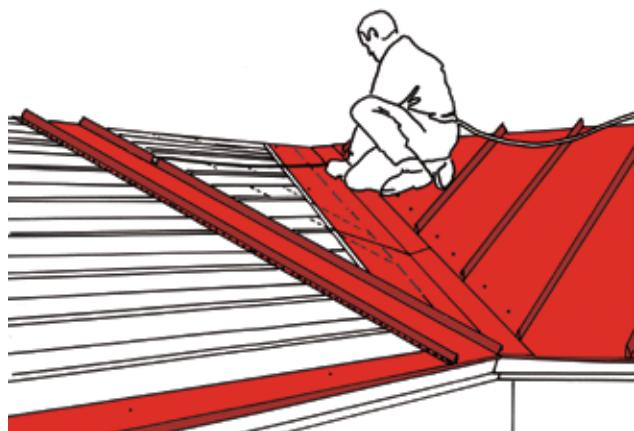
Отмерьте и начертите расположение листов кровельного покрытия до конька. Будьте внимательны: первый лист кровельного покрытия должен быть уложен от ориентира, начертенного на листе ендовой.
